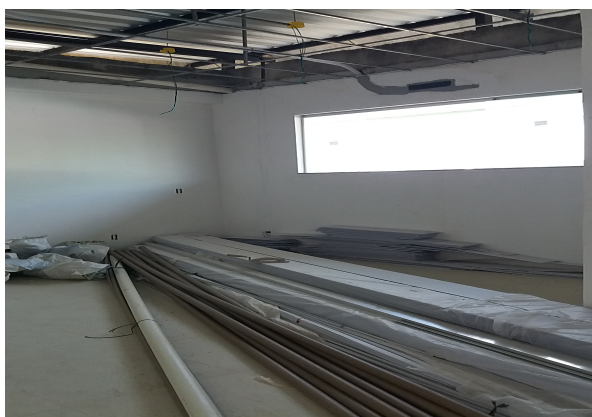
Figura 11: Área interna - bloco C
