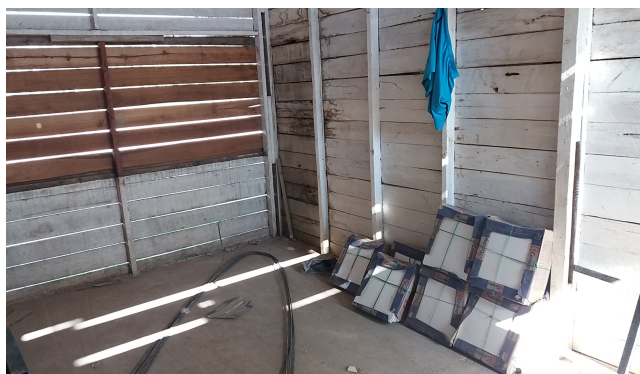
Figura 7: Área interna barracão
