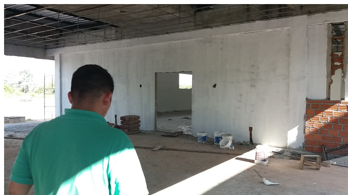
Figura 2: Parede realocada - bloco D
