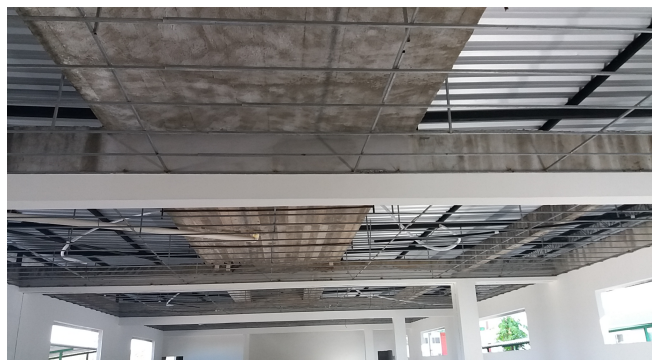
Figura 4: Estrutura do telhado - bloco D
