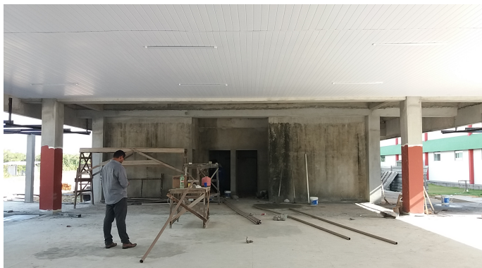
Figura 1: Área externa - bloco C
