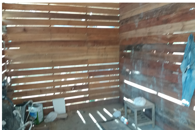
Figura 10: Área interna barracão
