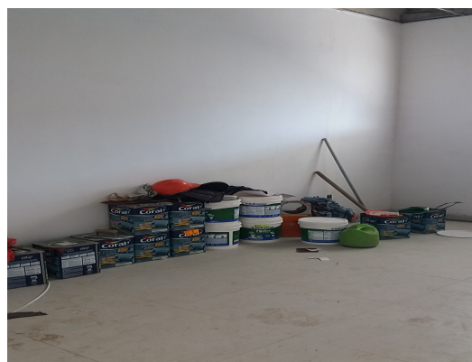
Figura 12: Área interna - bloco C
