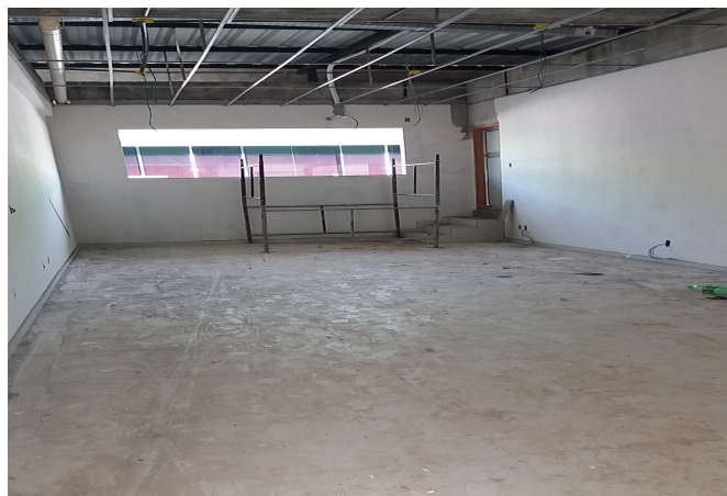
Figura 14: Área interna - bloco C
