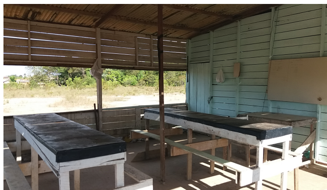
Figura 6: Área externa barracão
